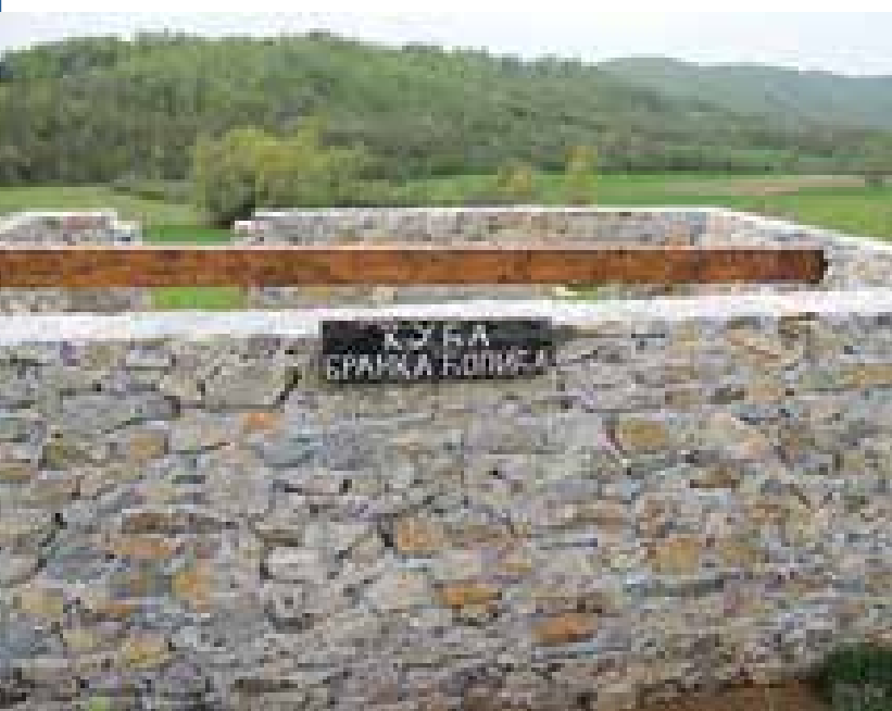
Kuća Branka Ćopića u izgradnji na mjestu bivšeg pomoćnog objekta uz staru kuću.
