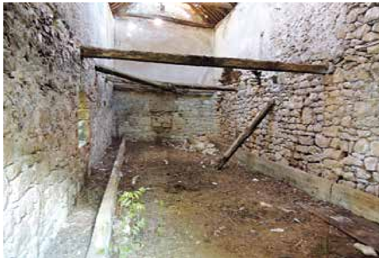
Pored zgrade za prijem žitarica, suknare u mlinskom kompleksu, dok su čekali da se žito samelje i konji su imali svoj poseban kutak sa jaslama za sijeno.
