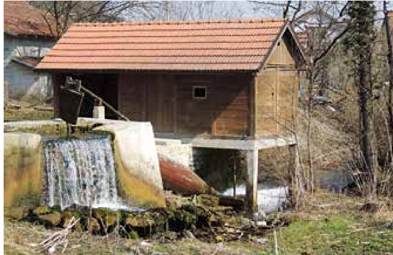
Novi mlin u Donjim Rakanima. Ispred mlina je ustava napravljena tako da se može iz mlina pomoću poluge usmjeriti voda na mlinsko kolo, a kada mlin ne radi, da se preliva preko brane u vodotok.
