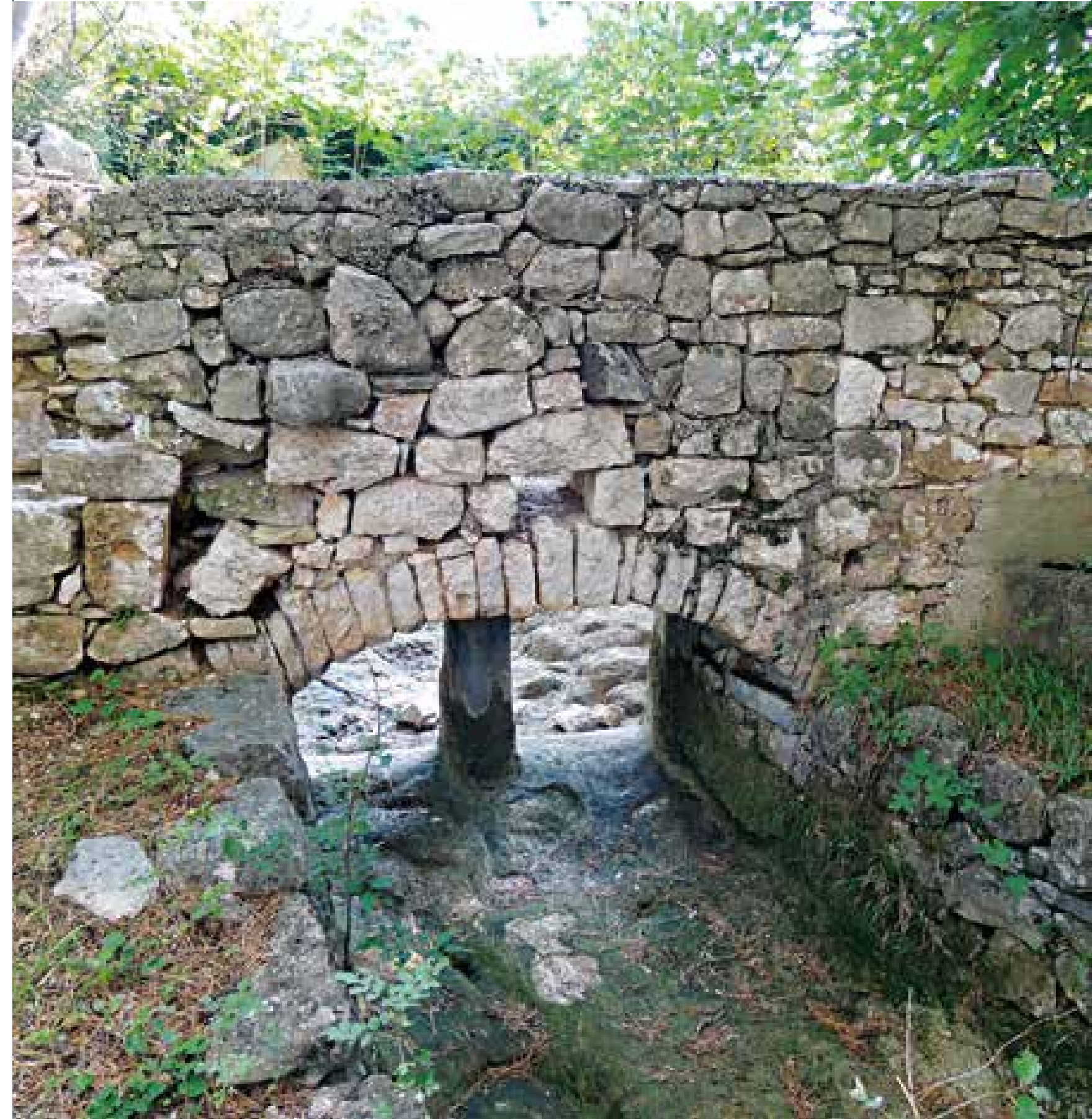
Za mlinove i suknaru izgrađeno je na stotine metara kanala koji su doveli vodu iz Zrmanje i vraćali je u rijeku.
