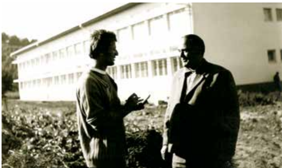
Novinar Zare Safić u razgovoru sa Draganom Antonićem povodom završetka radova na izgradnji nove školske zgrade u Donjim Agićima
