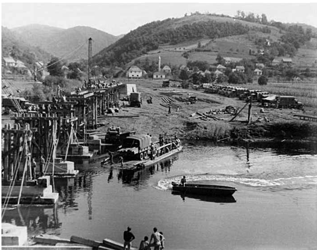
Nakon obimnih priprema, inženjeri JNA iz Karlovca u roku od desetak dana povezali dvije obale na rijeci Sani u Blagaju mostom u dužini od 140 metara
